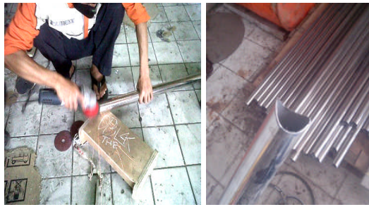
Gambar 3. Posisi Operator pada Proses Pencoakan Railing (Pipa Besi) yang Dilakukan secara Manual dengan Gerinda
