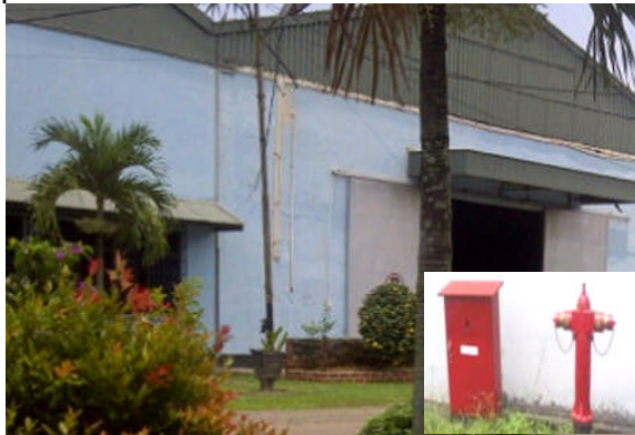
Gambar 17 Contoh Pemasangan Hydrant
